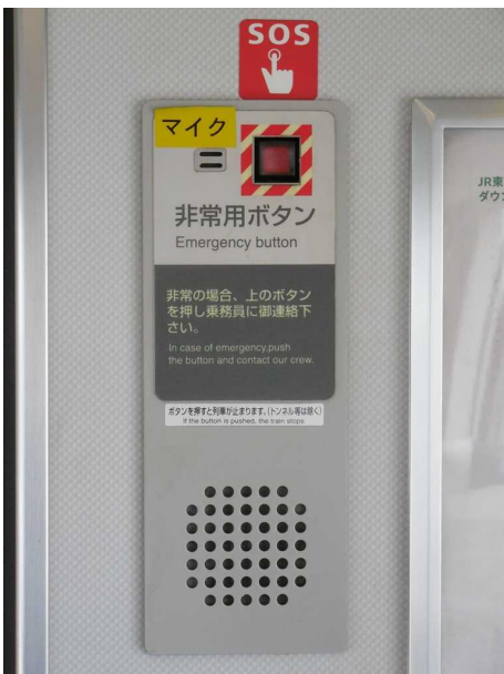
J R東日本E 2 5 7系5 0 0代の 車いす対応座席付近に設置されている 非常通話装置
