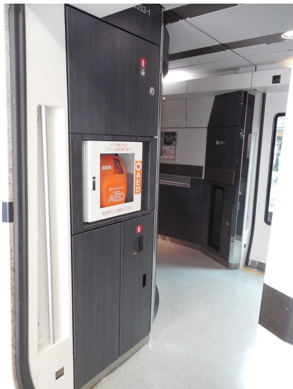
E353系の9号車のデッキに 備え付けられているAED 左奥が多機能トイレ
