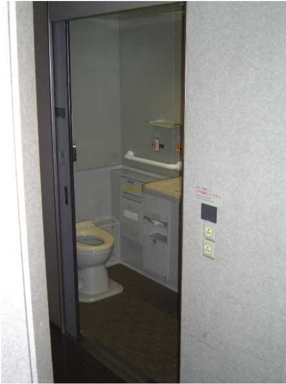
E1系9号車の多機能トイレ
