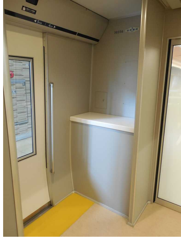
小田急電鉄30000形「EXE」の 4号車の公衆電話撤去跡 車いす非対応構造だったことがわかる
