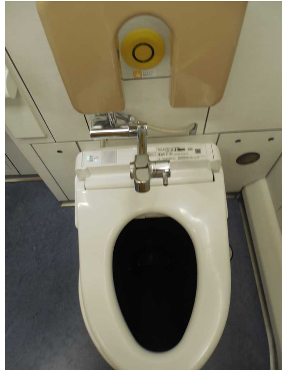
小田急電鉄70000形「GSE」の 多機能トイレ内のオストメイト対応設備
