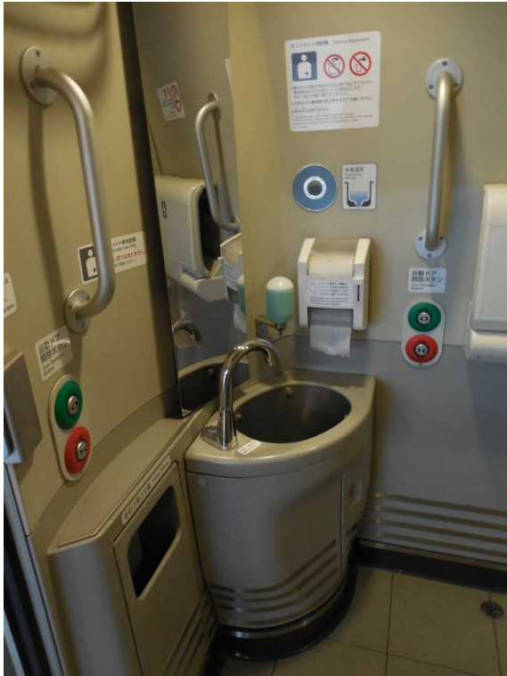
N700系の多機能トイレ内の オストメイト対応設備
