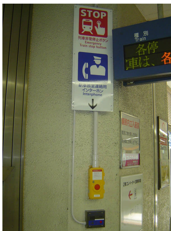
相模鉄道本線横浜駅構内の「列車非常停止ボタン」(上)と「駅事務室連絡用インターホン」(下)。後者には「このボタンを押しても列車は止まりません。」と記されたシールが貼ってある。（2008年4月3日撮影）
