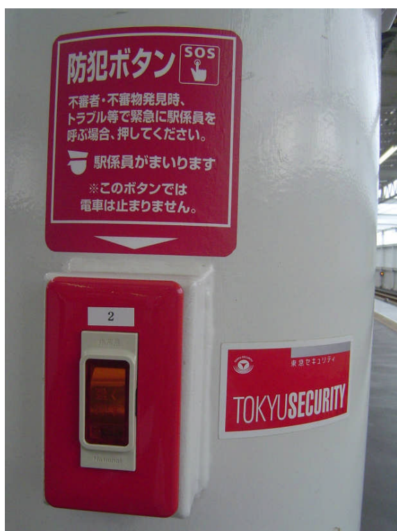
東京急行電鉄東横線元住吉駅構内の「防犯ボタン」。「このボタンでは電車は止まりません。」と明記されている。（2008年5月3日撮影）
