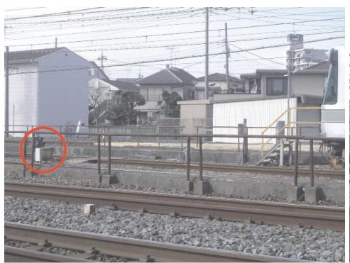
【写真1】引上4番線の第1入換信号機(赤丸内)。信号機の下の 「下中」表示は、停車中の東京メトロの車両(右端)に対して、 検車区へと続く下り中線への進行を指示している。検車区へ入庫 する列車では、信号係員が第38号踏切と第37号踏切の警報を 鳴らし始める操作をした後、遮断機が下りてから「下中」の表示 が出るように設定されている。始発列車の場合には、信号係員が 上り緩行線への進行を意味する「上緩」を表示させた後、列車が「右上の斜めに並んでいるときは進行可を意味する。 この信号機を通過した瞬間に第37号踏切の警報が鳴り始める。
