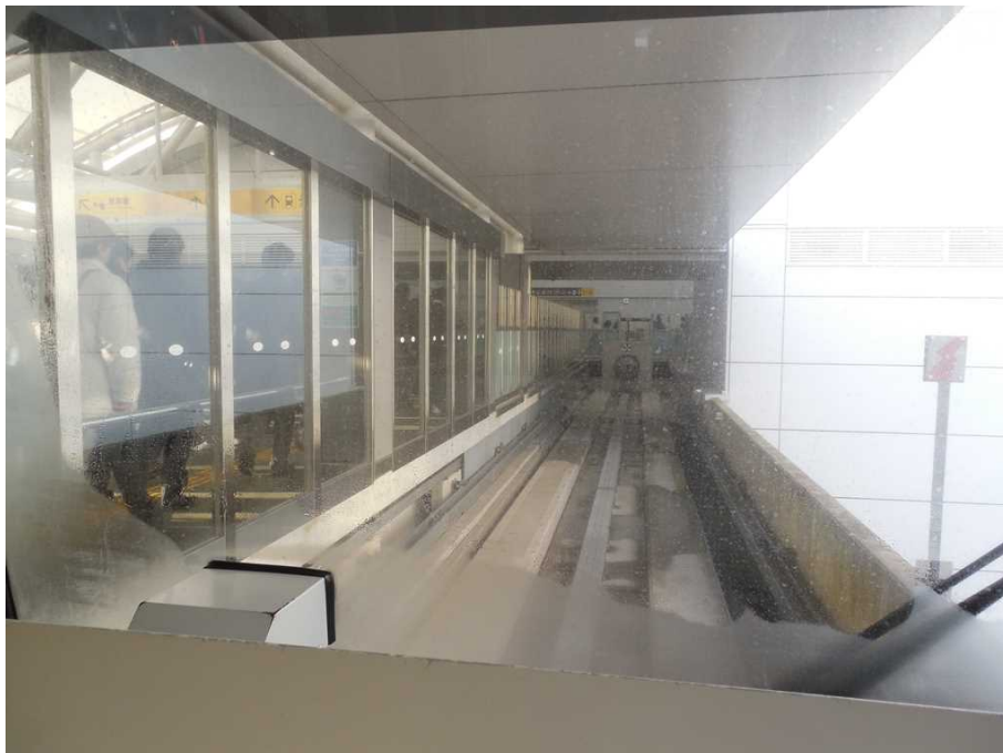
【写真2】日暮里駅の1番線に停車中の車内から見た、列車の停止位置から車止め方向へ車両1両分多く設置されているホームドア設置用の壁。建設時に将来の増結＝ホームドア増設を想定していなかったのだとしたら、わざわざこのような建設費が割高となる準備工事を行うのはおかしい(奥の車止め付近に見える簡易な柵で十分なはず)。画面右の稲妻形の標識は饋電(きでん＝送電)線の終端部を示す。(2014年1月22日に撮影)
