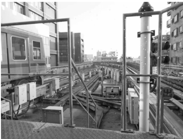
【写真 2】日暮里駅のホーム終端部から、2 番線(画面右側)から下り列車が出発するための渡り線を見る。渡り線がホーム終端のすぐ近くに設置されているため、ホーム延伸の障害になってしまっているのがわかる。上り列車が 1 番線(画面左側)に到着するための渡り線は、左折した先のビルの陰に設置されている。
