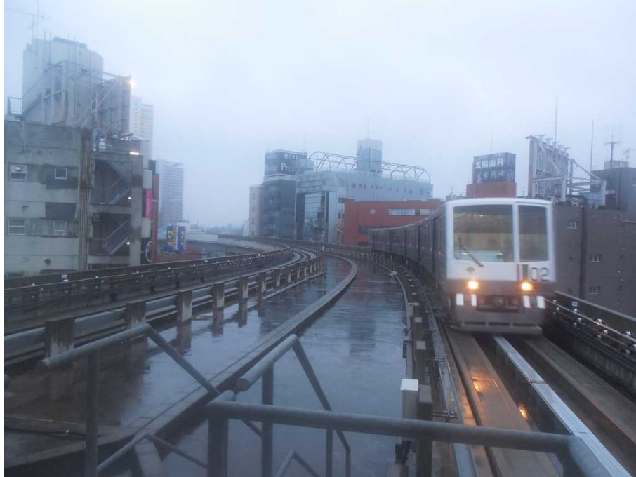
【写真3】西日暮里駅のホームから日暮里方の軌道を見たところ。上り線と下り線との間には軌道保守作業車用の留置線を設置するのに十分な空間がある。空間の中央に見えているのは信号ケーブルを収容したU字溝で、左右にずらす移設は容易。列車は下り見沼代親水公園行き。(2015年2月18日に撮影)
