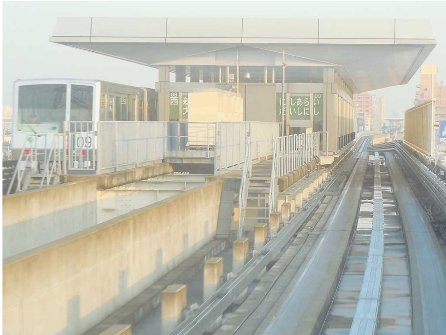
【写真1】西新井大師西駅の南側に設置されている、将来のホーム延伸に備えた基礎と思われる部分。他の各駅にも同様の設備がある。 (2014年1月22日に日暮里行き列車の最後部から撮影)
