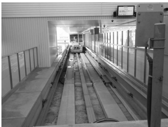
【写真 3】日暮里駅 1 番線の車止めから見た、列車の停止位置。車止めから列車停止位置までの過走余裕距離は約 25m。この部
