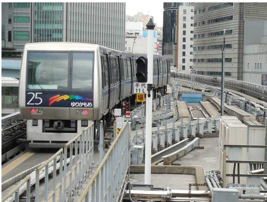
【写真4】ゆりかもめ汐留駅のホームから見た、軌道保守作業車用の留置線（新橋行き列車の右側に見えている行き止まりの部分。2015年1月7日に撮影）
