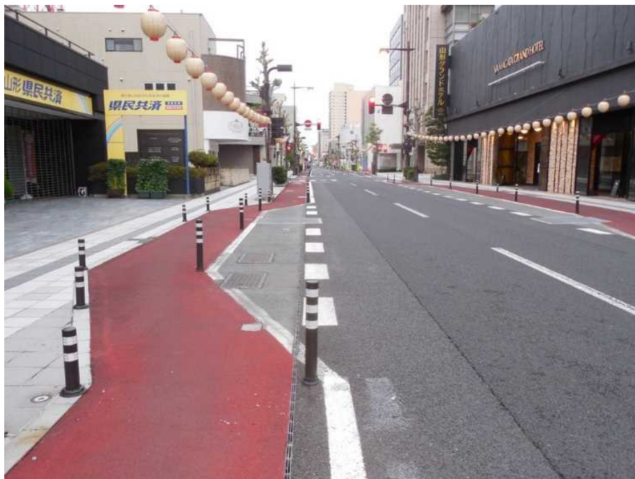
【南行14】山形グランドホテル（画面右上）付近の自動車停車帯で自転車道が屈折している様子。この付近では道路の左右両側に自動車停車帯がある。
