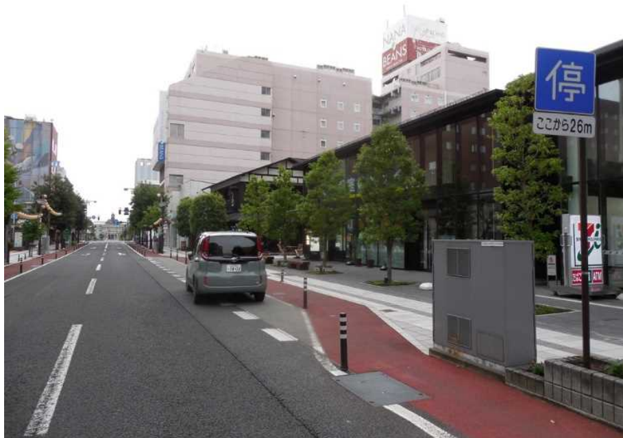
【北行36】七日町バス停の北の交差点の先で自動車が停車帯に停車している様子・その2。 停車帯の切り欠きが浅いため、大型車が停車すると本線の自動車の流れを妨げ渋滞を誘発することもある。
