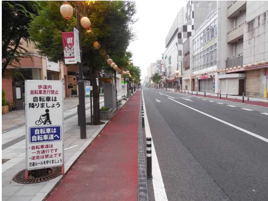
【南行09】旧大沼デパート付近に設置された、歩道内自転車走行禁止の看板。
