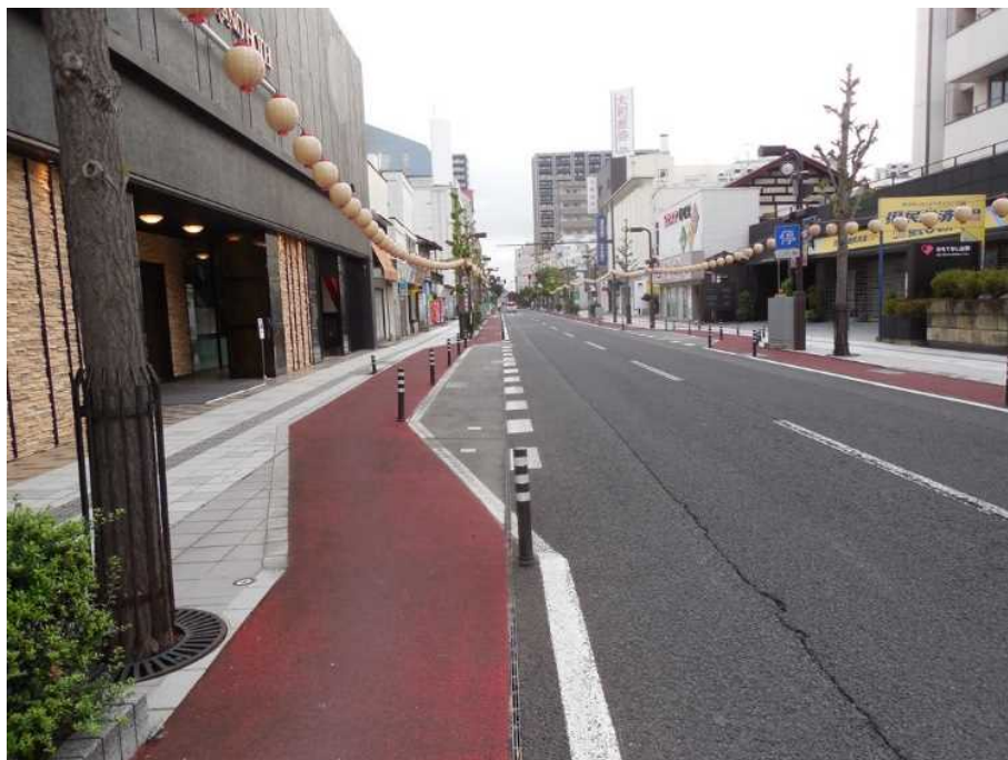
【北行22】山形グランドホテル前の自動車停車帯で自転車道が屈折している様子。ホテル利用者のタクシー乗降に配慮して設置したと思われる。
