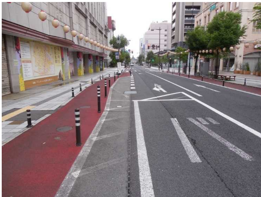
【北行32】七日町バス停と一体的に設置された自動車停車帯（バス停の前方）。左は旧大沼百貨店（2020年に破産）。
