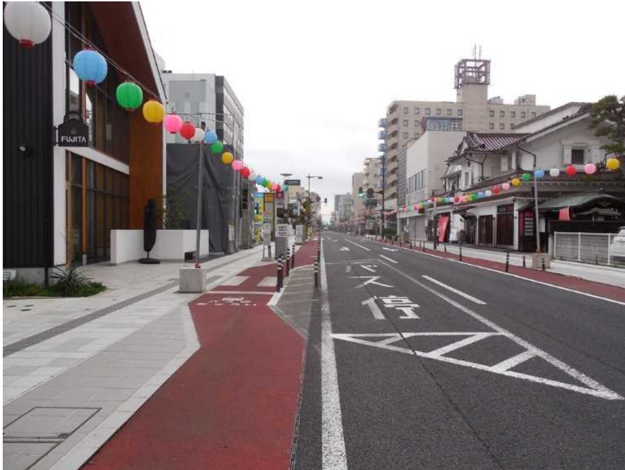
【北行7】十日町紅の蔵前バス停で自転車道が屈折している様子。自転車道とバス停バスとの間に島を設けてバス乗降客の安全を確保するための措置。よく見ると画面左の歩道から右の車道までの間に段差が全く無いことがわかる。
