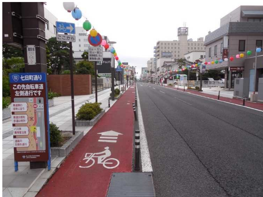
【北行4】十日町交差点から北へ向かう自転車道の起点。自転車道部分の路面が赤く色分けされ、自動車用の車道との間には簡易ボールの仕切りが設置されている。
