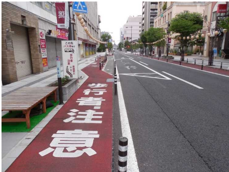
【北行30】七日町バス停で自転車道が屈折している様子・その1。
