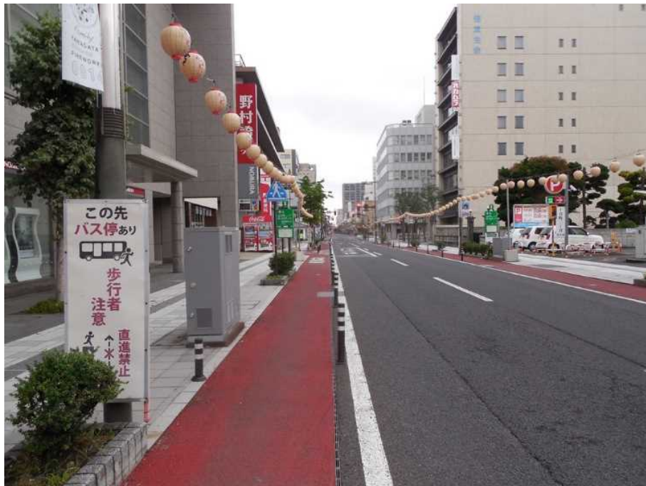
【北行12】この先のバス停で歩行者（バス乗降客）への注意を促す看板。看板の一部が手前の植栽に隠され見えなくなっている。
