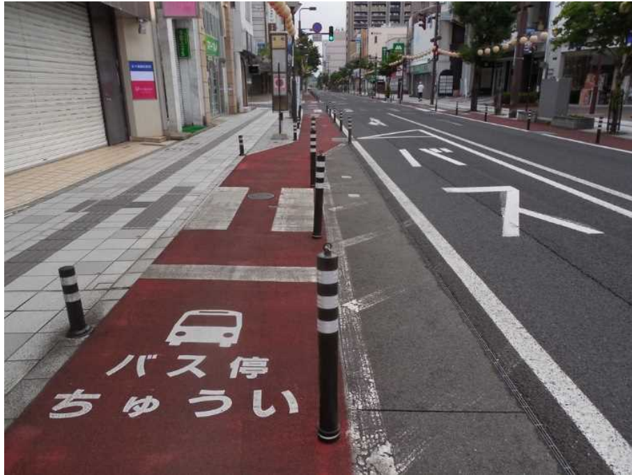
【北行25】本町バス停でバス乗降客のため自転車道に設置された横断歩道。バスに乗る人は歩道でバスを待ち、バスが停車してから自転車道部分の横断歩道を渡って乗車するよう案内されている。
