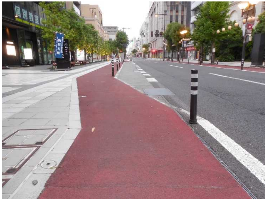
【南行06】御殿堰付近の自動車停車帯で自転車道が屈折している様子・その2。よく見ると画面左の歩道から右の車道までの間に段差が全く無いことがわかる。
