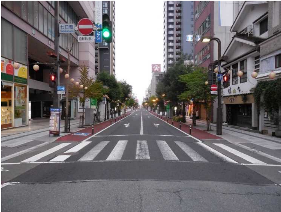
【南行01】七日町交差点に設置された道路標識類。ここは国道112号線の一方通行の出口に当たり、自転車以外の車両は進入できない。
