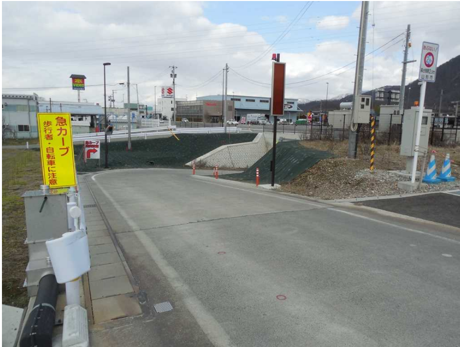
1 3. 東西連絡道路が国道13号をアンダークロスするトンネルの西詰付近。
