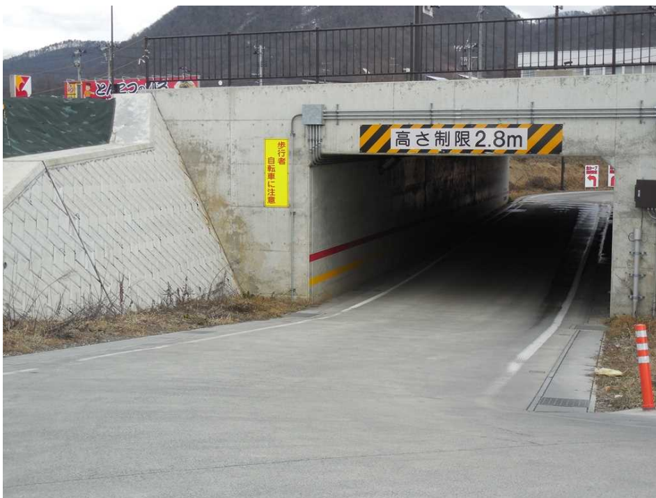
1 4. 東西連絡道路が国道13号をアンダークロスするトンネルの内部を 西側から見たところ。
