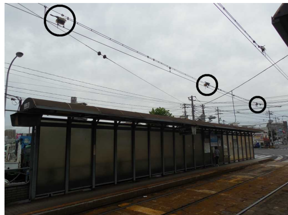
【写真2】皆実町六丁目電停の分岐器制御用トロリーコンタクター(架線上の3つの円内)。
