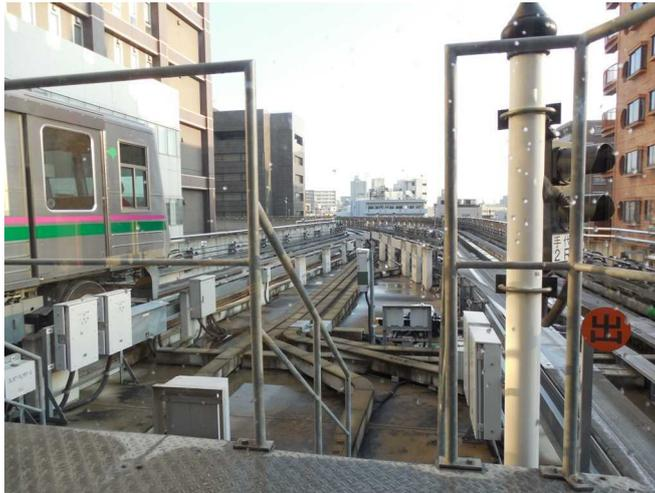
【写真2】日暮里駅のホーム終端部から、2番線（画面右側）から下り列車が出発するための渡り線を見る。渡り線がホーム終端のすぐ近くに設置されているため、ホーム延伸の障害になってしまっているのがわかる。上り列車が1番線（画面左側）に到着するための渡り線は、左折した先のビル影に設置されている。
