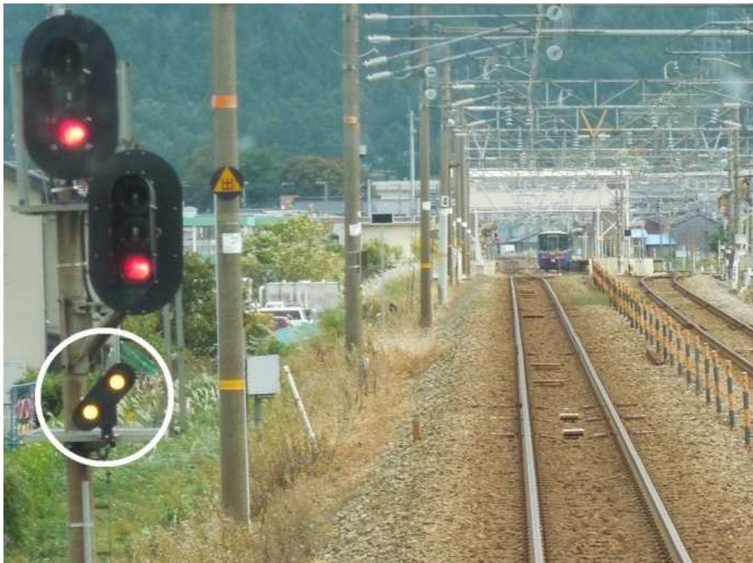
【写真1】泊駅構内下り線の誘導信号機(○印)が、トキ鉄の車両がいる中線への進入を許可している。進入速度は15km/h以下。山が迫っている背後の地形にも注目。(441Mの運転席の背後から撮影)
